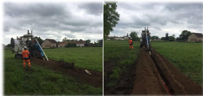
Figure 4 Exemple de chantier d'enfouissement d'un réseau électrique en terres agricoles (source : Cegelec infra)
